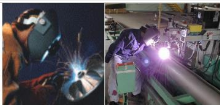
Fig.3: Soldadura parcialmente mecanizada e totalmente mecanizada
