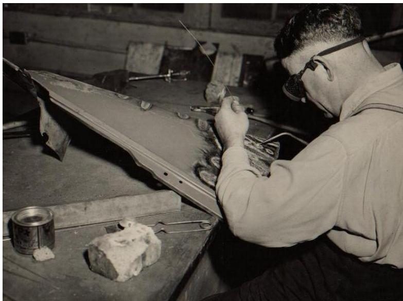
Figura 1.1: saldatura a gas ossiacetilenico (riparazione del telaio), 1949
